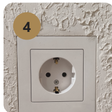
Механизм и рамка фурнитура Atlas Design заподлицо
