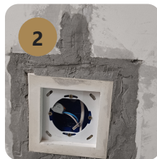
Прикрутите и выровняйте вровень со стеной, замажьте зазор
